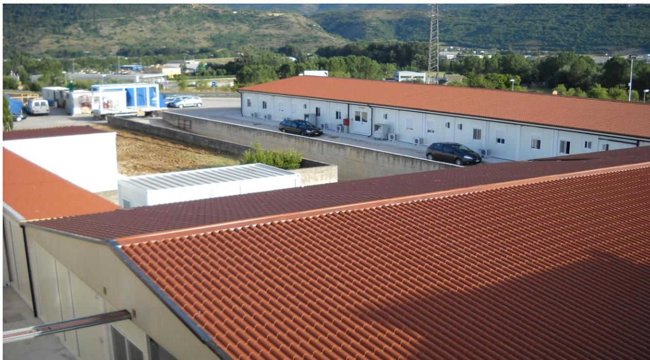
Nel caso si debbano effettuare collegamenti alla struttura esistente e/o effettuare aree di lavoro adiacenti alla sala operatoria (spogliatoi – zona risveglio ecc.) verranno impiegati strutture modulari prefabbricate. Tali moduli sono facilmente posizionabili e, vista la modularità, risultano essere totalmente flessibili consentendo la realizzazione delle più disparate configurazioni logistiche.
