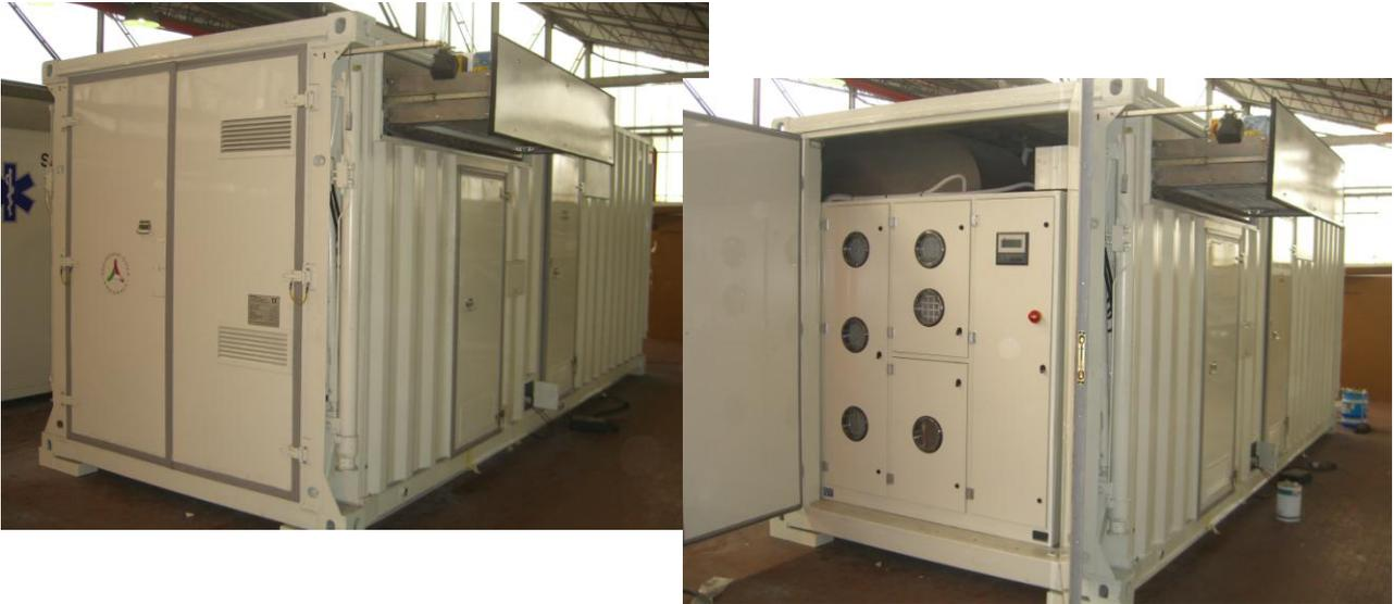
Il container tecnico, allestito su modulo ISO 20" 1 CC, ha la funzione di contenere tutti gli impianti necessari al funzionamento autonomo della sala operatoria:
